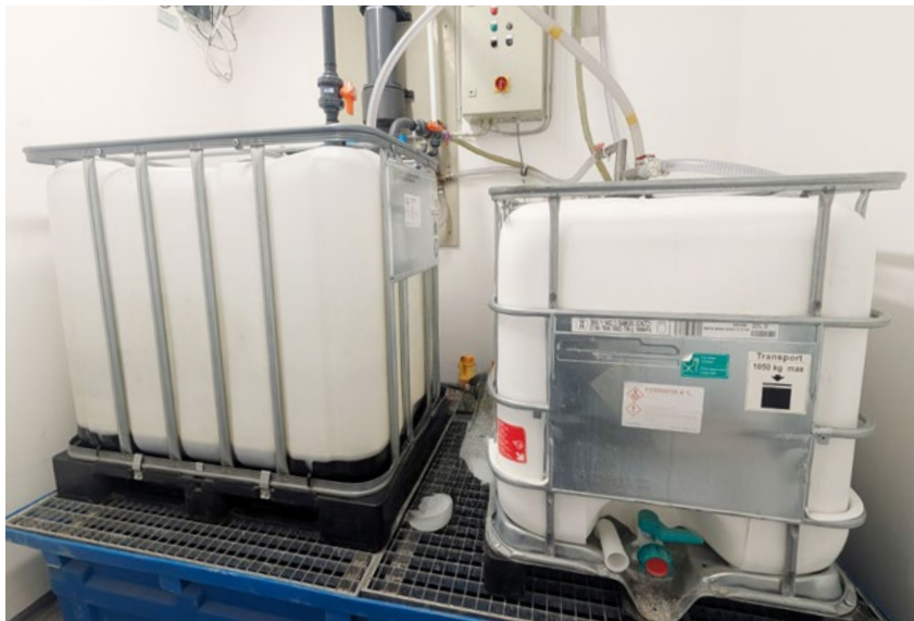
Alt-Formalin-Recyclingsystem im Keller der Pathologie Trier
